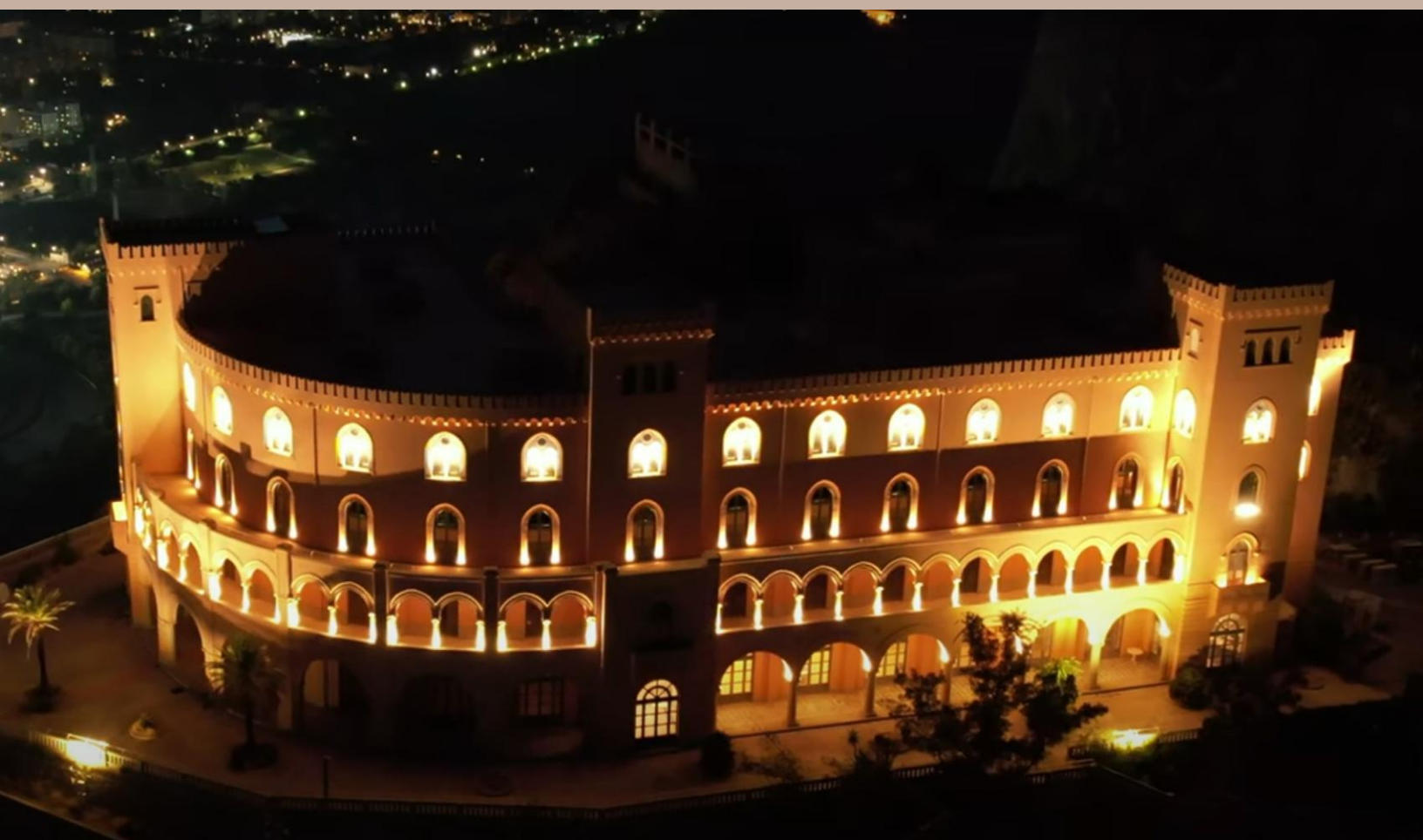
Zamek Utveggi – Zabieg poprawy efektywności energetycznej z zastosowaniem cyklu RasoThermo + Reflex-out.
